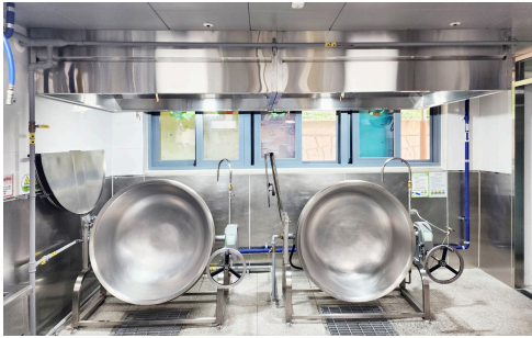
국솥, 볶음솥 옆 직접 급수 설치
